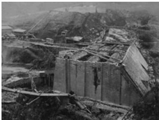
大正12(1923)年3月の工事中の写真
